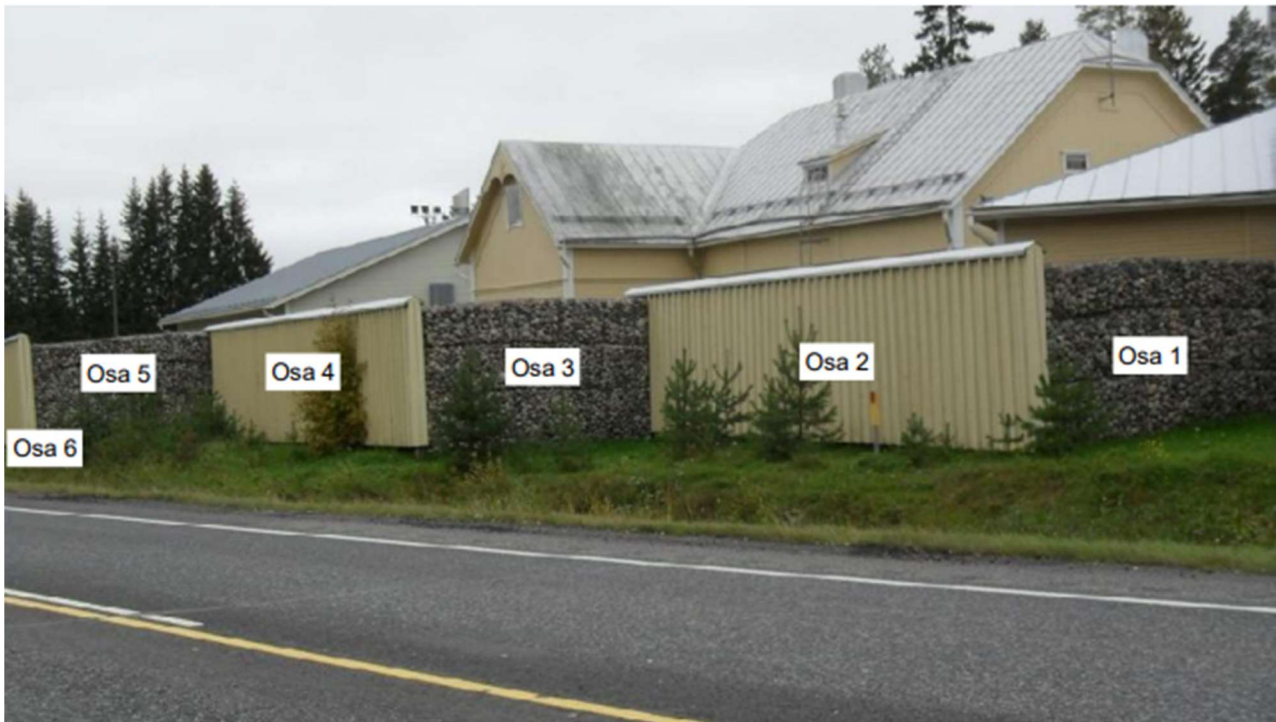
Kuva 8. Meluseinän jakaminen osiin meluntorjuntarakenteen muuttuessa (puuelementti ja kivikori).
