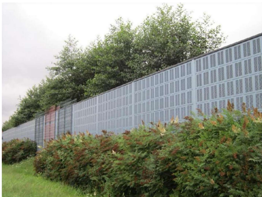
Kuva 15. Meluntorjuntarakenteena teräskasetti.
