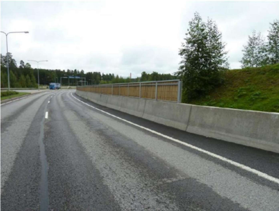
Kuva 4. Betoninen tien melukaide (Tievelho), jonka päällä puuelementtinen meluseinä (Taitorakennerekisteri).
