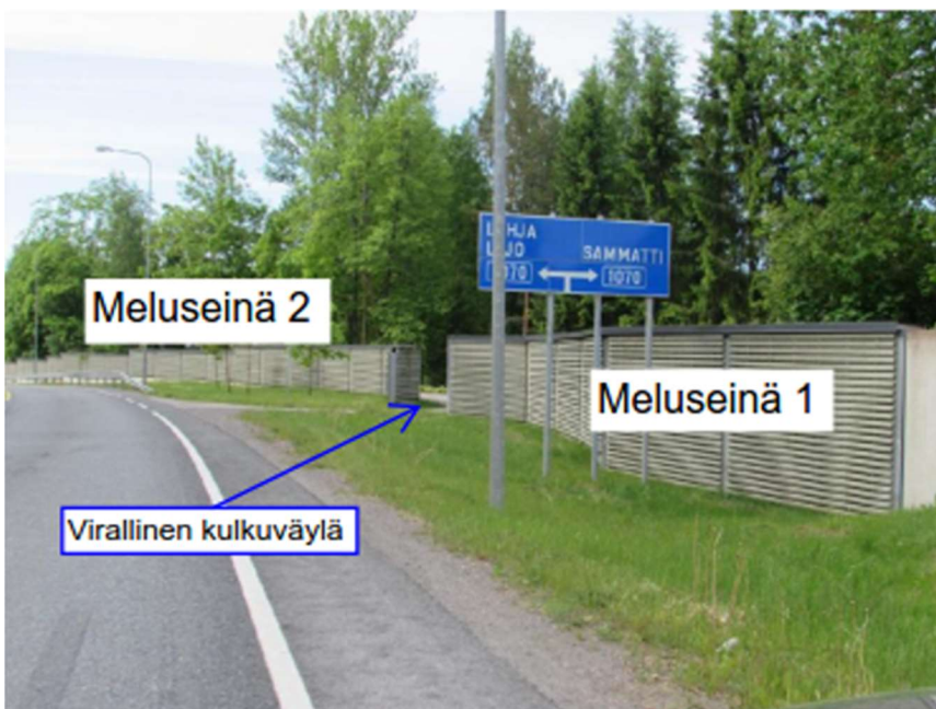
Kuva 8. Meluseinän jakaminen osiin meluntorjuntarakenteen muuttuessa (puuelementti ja kivikori).
