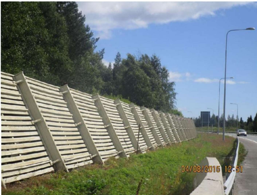
Kuva 17. Meluntorjuntarakenteena puukasetti / puuelementti .
