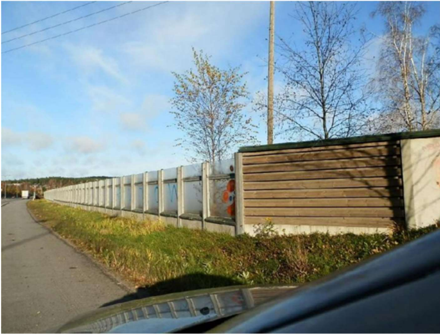
Kuva 18. Meluntorjuntarakenteina lasielementti ja betonielementti.
