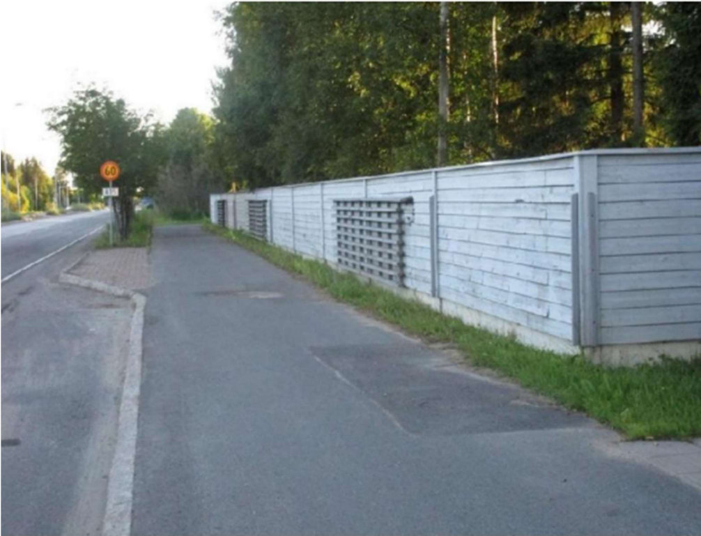
Kuva 20. Meluseinän osan asemointi itsenäinen .
