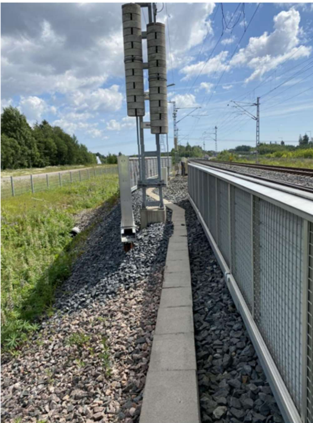
Kuva 23. Meluseinän asemointi radan matala melueste .
