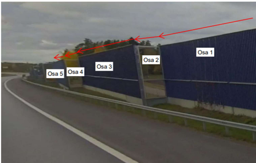
Kuva 6. Meluseinän osien muodostaminen meluntorjuntarakenteen muuttuessa.
