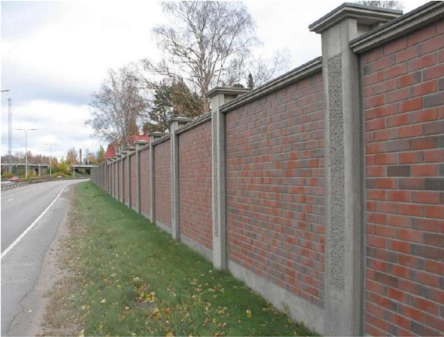
Kuva 16. Meluntorjuntarakenteena betonielementti , tiiliverhous.
