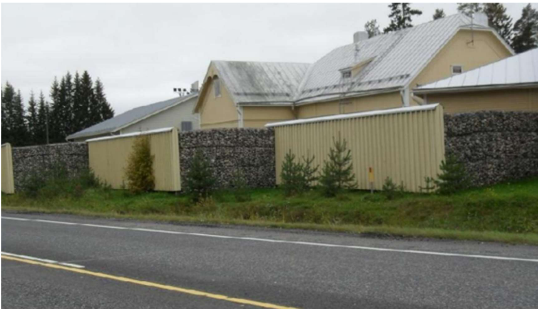
Kuva 19. Meluntorjuntarakenteina puukasetti / puuelementti sekä kivikori.
