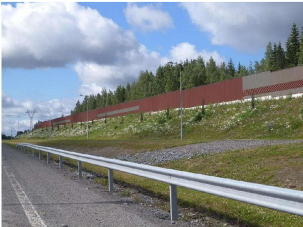
Kuva 21. Meluseinän osan asemointi meluvallin päällä .
