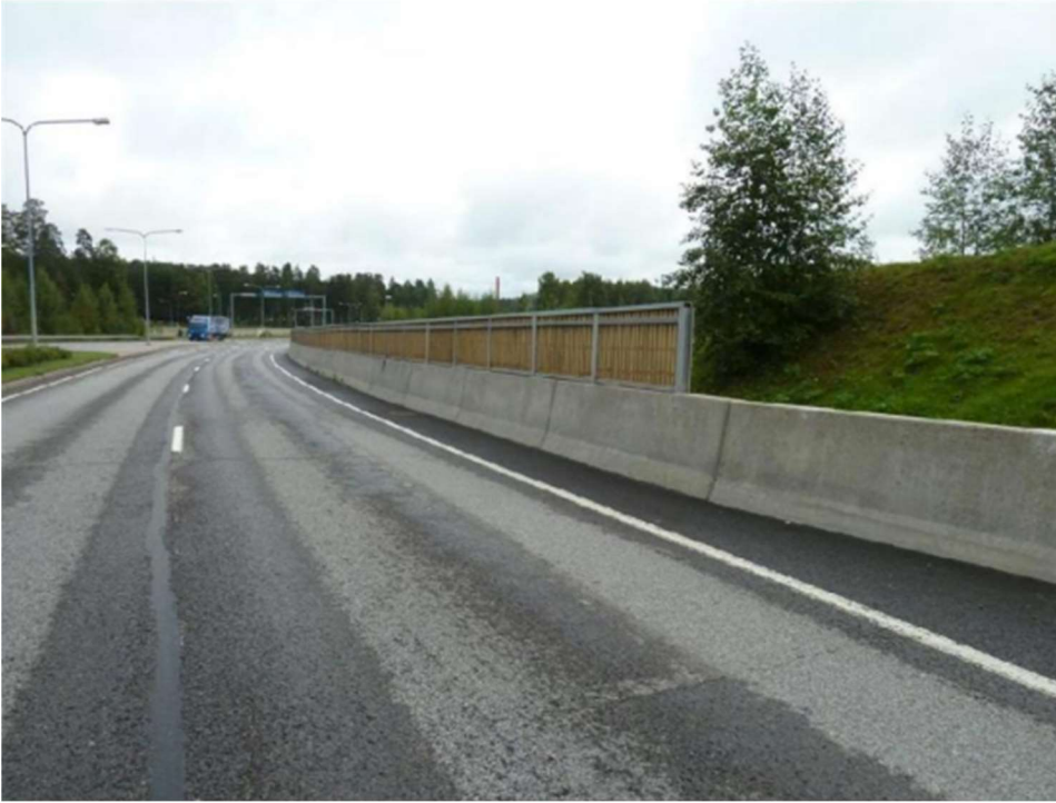
Kuva 22. Meluseinän osan asemointi kaiteen päällä .
