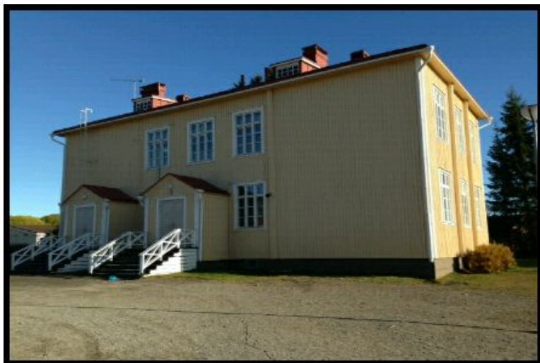
rakennus B (2 krs), sr-2
